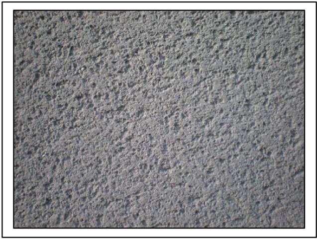
Monocouche projeté finition gratté, ton gris foncé
